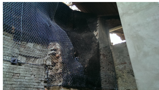
Detail stabilizace v nepřístupném místě pod přístřeškem
