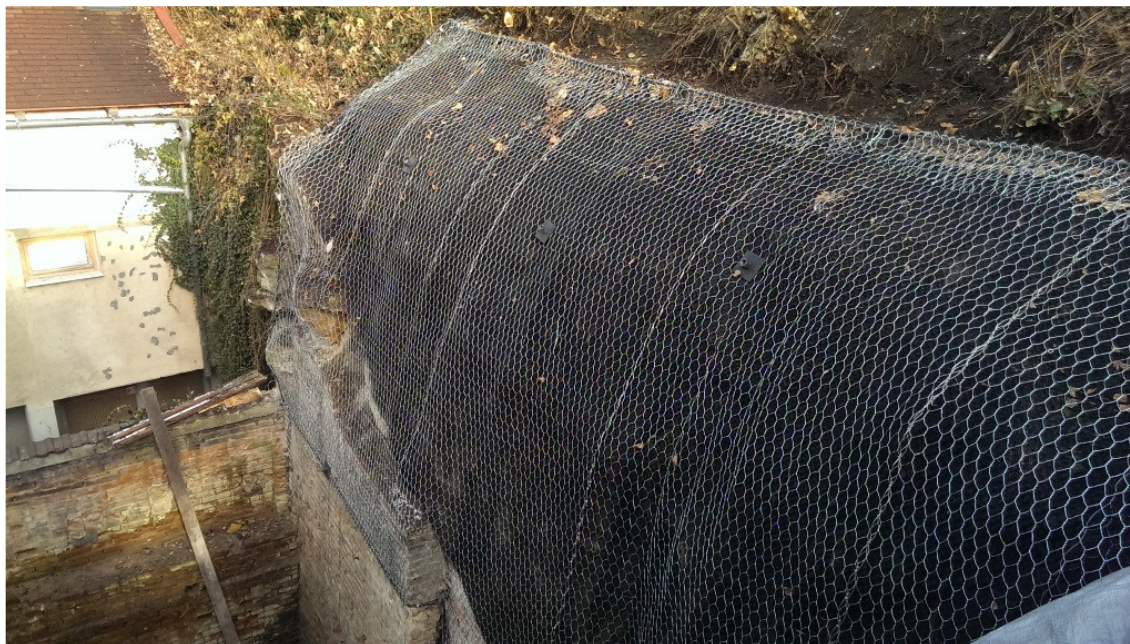
Stabilizovaná koruna opěrné zdi
