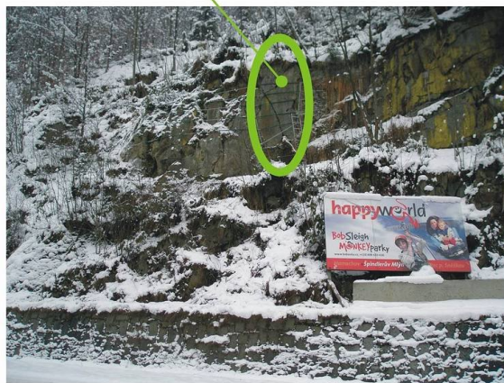
Fotodokumentace stavu po stabilizaci
