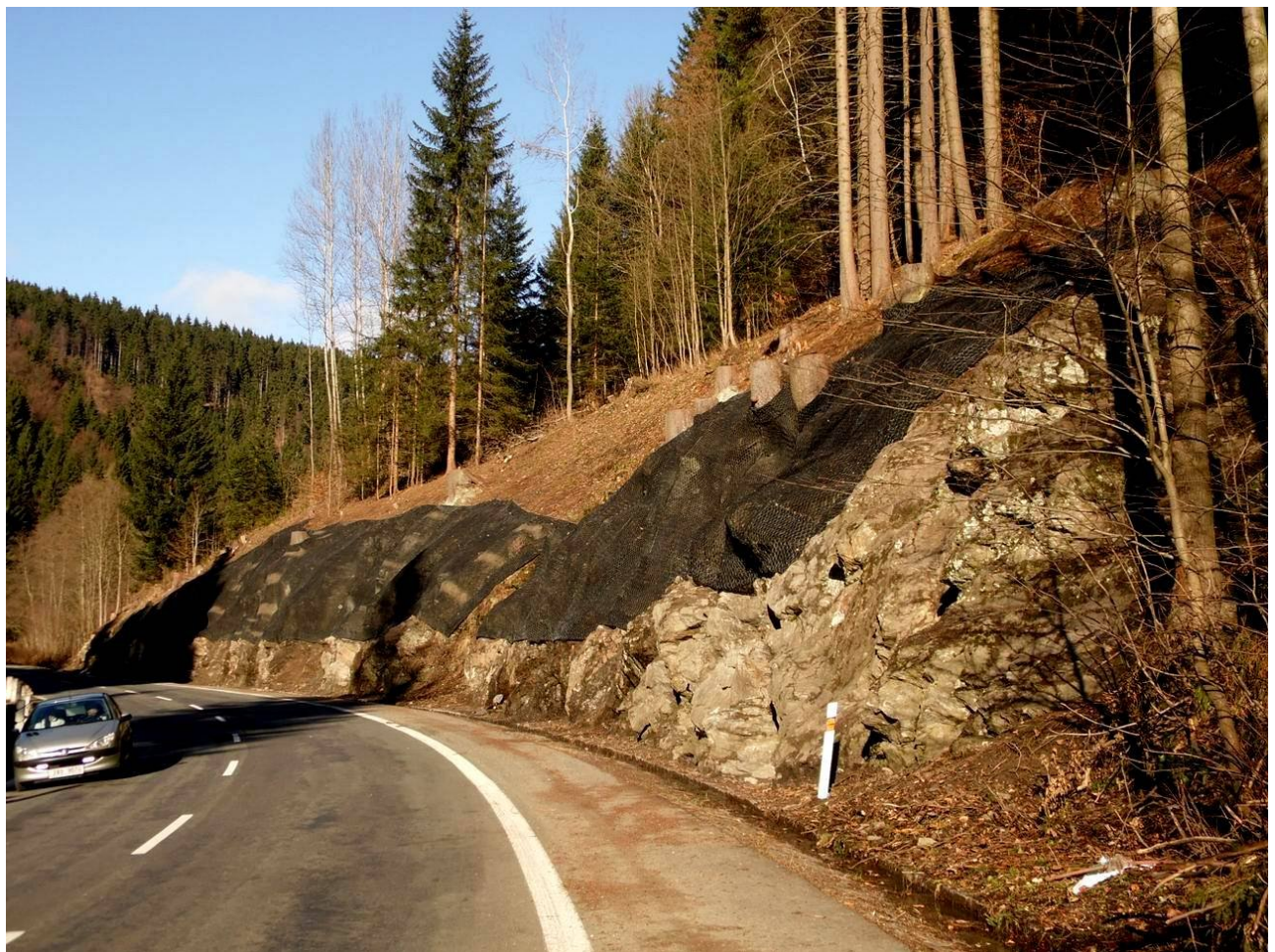
U Čisté Vody - finální podoba skalního svahu stabilizovaného záchytnými sítěmi 11. 11. 2013
