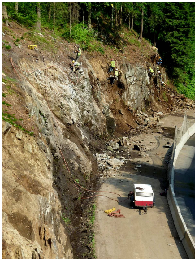
Nad Michlákem - odlomy nestabilních skalních částí a bourací práce ve skalním svahu 13. 07. 2010
