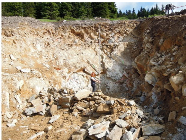
Výkop základové jámy (červen 2015)
