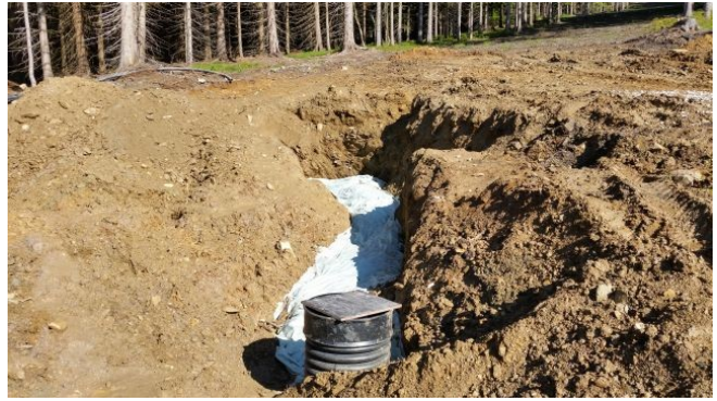
Terénní zářez u dolní stanice lanové dráhy (zkr.DS LD / Podchycení průsaku vody u podpěry C2 jím.šachtou a drenáží (konec dubna 2015)
