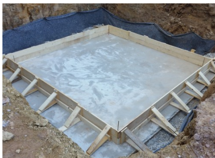
Výkop základové jámy a betonáž podkladního betonu (červen 2015)
