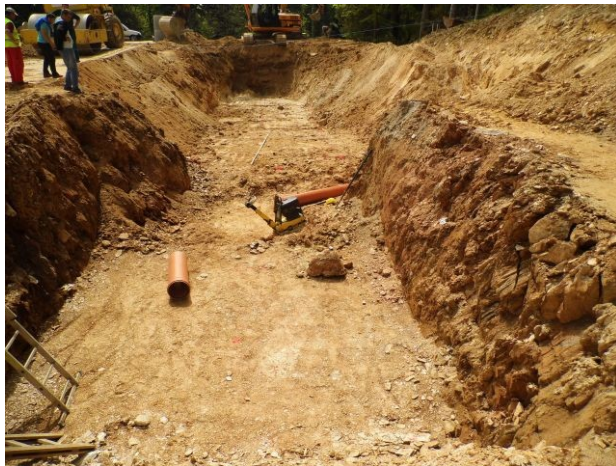
Výkop pro založení sloupové podpěry C1
