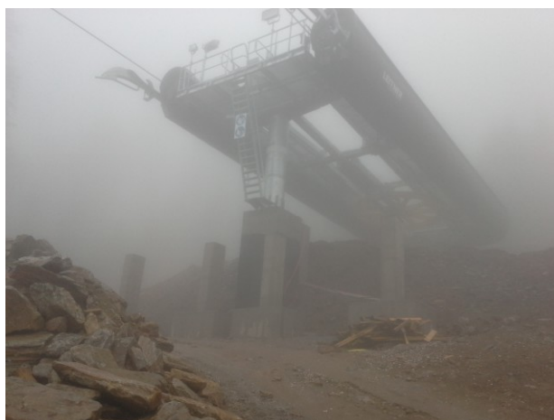
Stav těsně před dokončením (říjen 2015)
