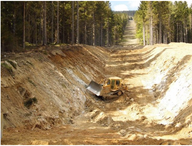
Terénní zářez u dolní stanice lanové dráhy (zkr.DS LD / Podchycení průsaku vody u podpěry C2 jím.šachtou a drenáží (konec dubna 2015)
