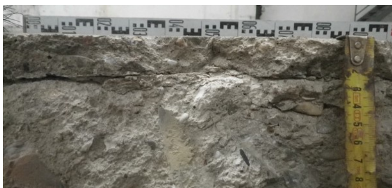
Dobře patrná horizontální trhlina pod svrchní betonovou vrstvou
