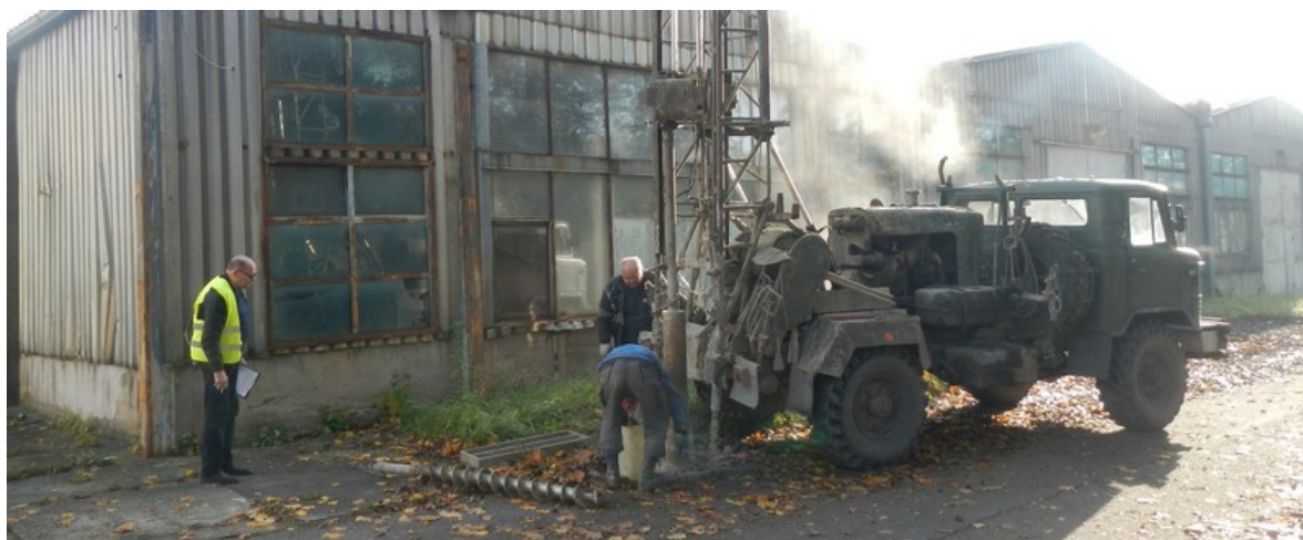
Vrtné práce prováděné vrtnou soupravou UGB na kolovém podvozku GAZ, Milan Bartoš, (10/2017)
