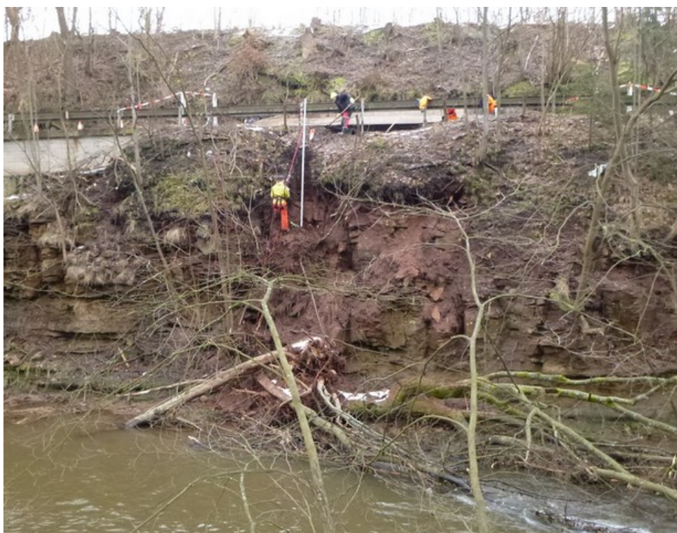
Celkový pohled na sesuv
