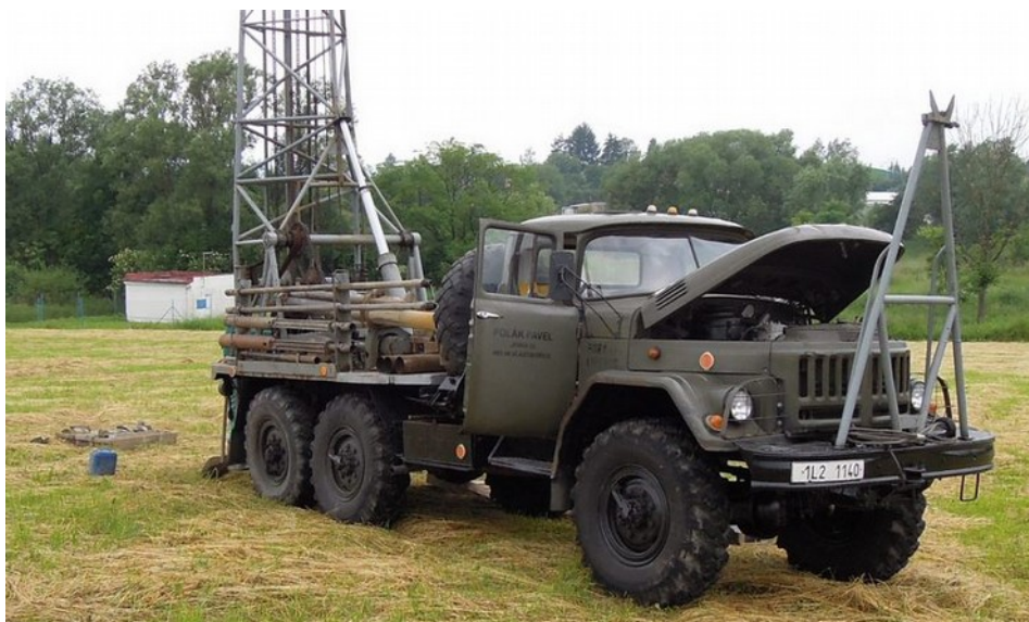
Vrtné práce prováděné vrtnou soupravou URB na kolovém podvozku ZIL, Pavel Polák, Vlastibořice-Jivina (06/2016)
